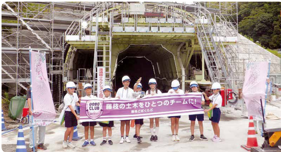
▲ まちづくり講座の様子(国道1号藤枝バイパス現場見学会)
